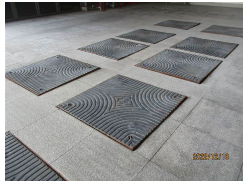
ภาพที่ 2-10 ระบบบำบัดน้ำเสียขั้นต้นใต้สถานี
