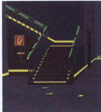
๔.๕ แถบเรืองแสงบันไดและแถบกันลื่น ติดเต็มความยาวของบันไดทุกชั้นบันไดในช่องทางหนีไฟ แถบเรืองแสงความกว้างไม่ต่ำกว่า ๖ มิลลิเมตร และขนาดความกว้างรวมแถบกันลื่นแล้วไม่ต่ำกว่า ๒๕.๔ มิลลิเมตร
